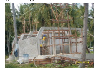
Nurdachhaus 120 m 2 - im Bau
