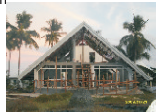
Nurdachhaus 440 m 2 - im Bau
